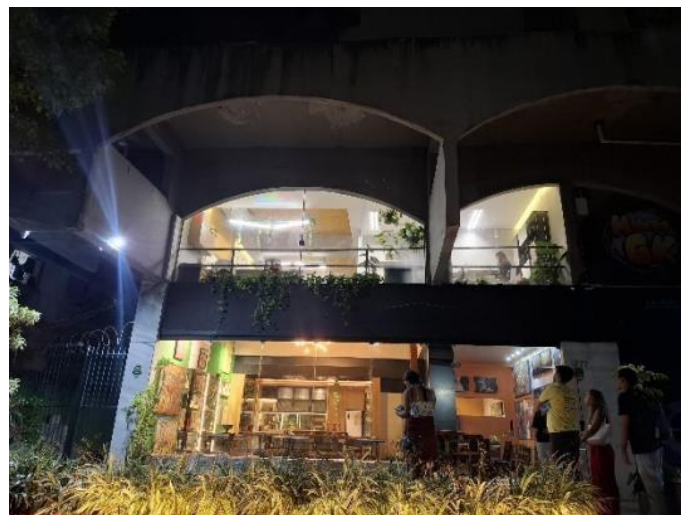
Figura 3- Fachada. Fonte: Autoria própria,2025
