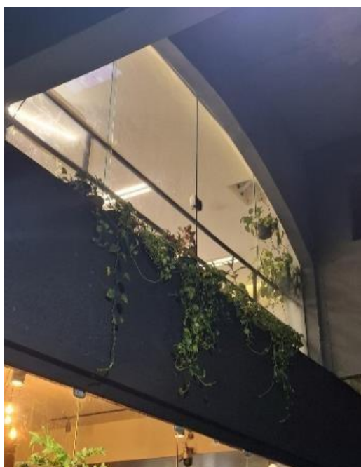
Figura 4- Fachada Fonte: Autoria própria,2025
