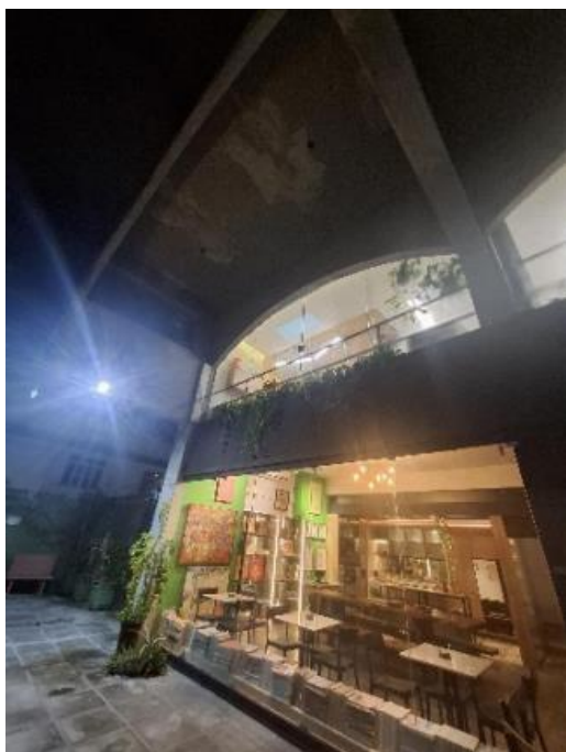
Figura 2- Fachada Fonte: Autoria própria,2025.
